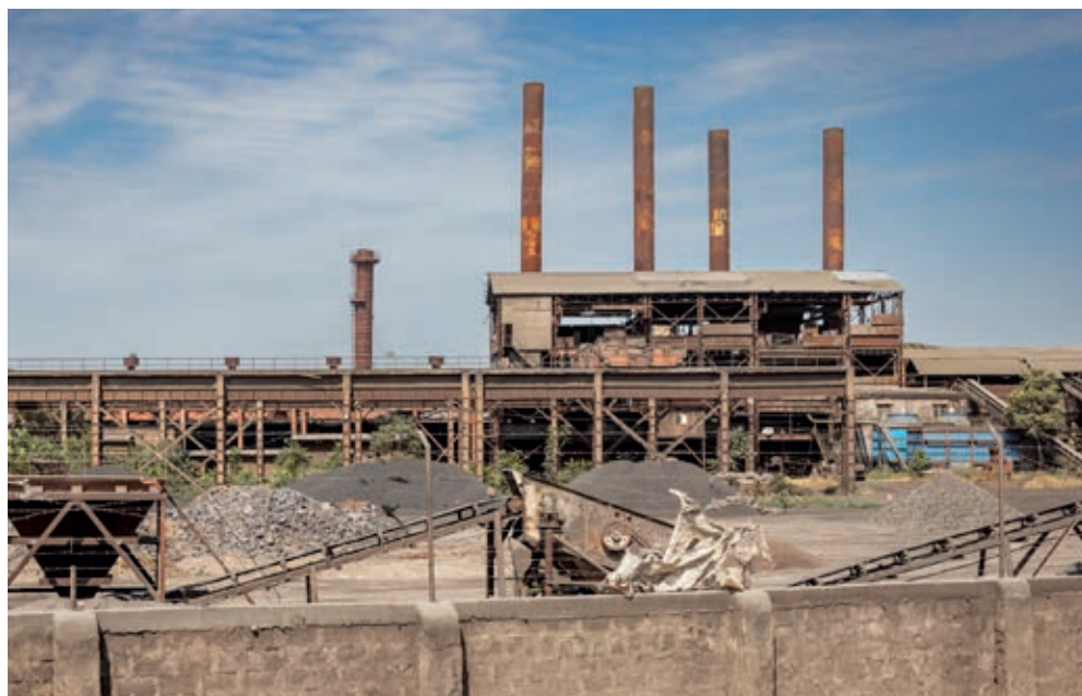
შპს "რუსელოისი", ფეროშენადნობთა ქარხანა. ფოტო: ონდრეი პეტრლიკ.
